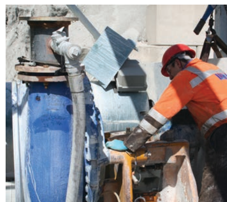
Obsługa techniczna pomp do żwiru Warman® w miejscu ich pracy
